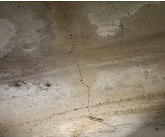
2#涵洞裂缝
