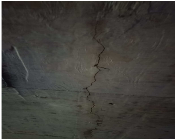
3#涵洞裂缝
