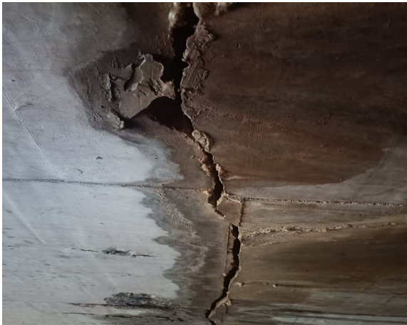
3#涵洞裂缝
