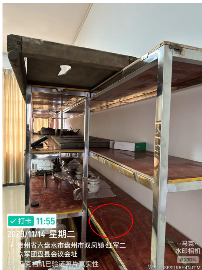
图 11 库房内文物储藏柜层板为胶水制作大芯板
